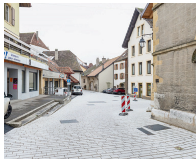
Les quelque 1100 m2 de la deuxième phase du chantier de Saint-Blaise seront recouverts des mêmes boutisses que celles utilisées ici pour la première phase. LUCAS VUITEL
