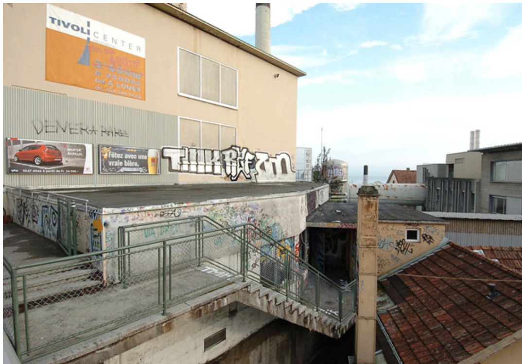
C'est en lieu et place des friches de l'ancienne usine Suchard que devrait s'ériger le projet immobilier de Tivoli Center SA. ARCHIVES RICHARD LEUENBERGER
